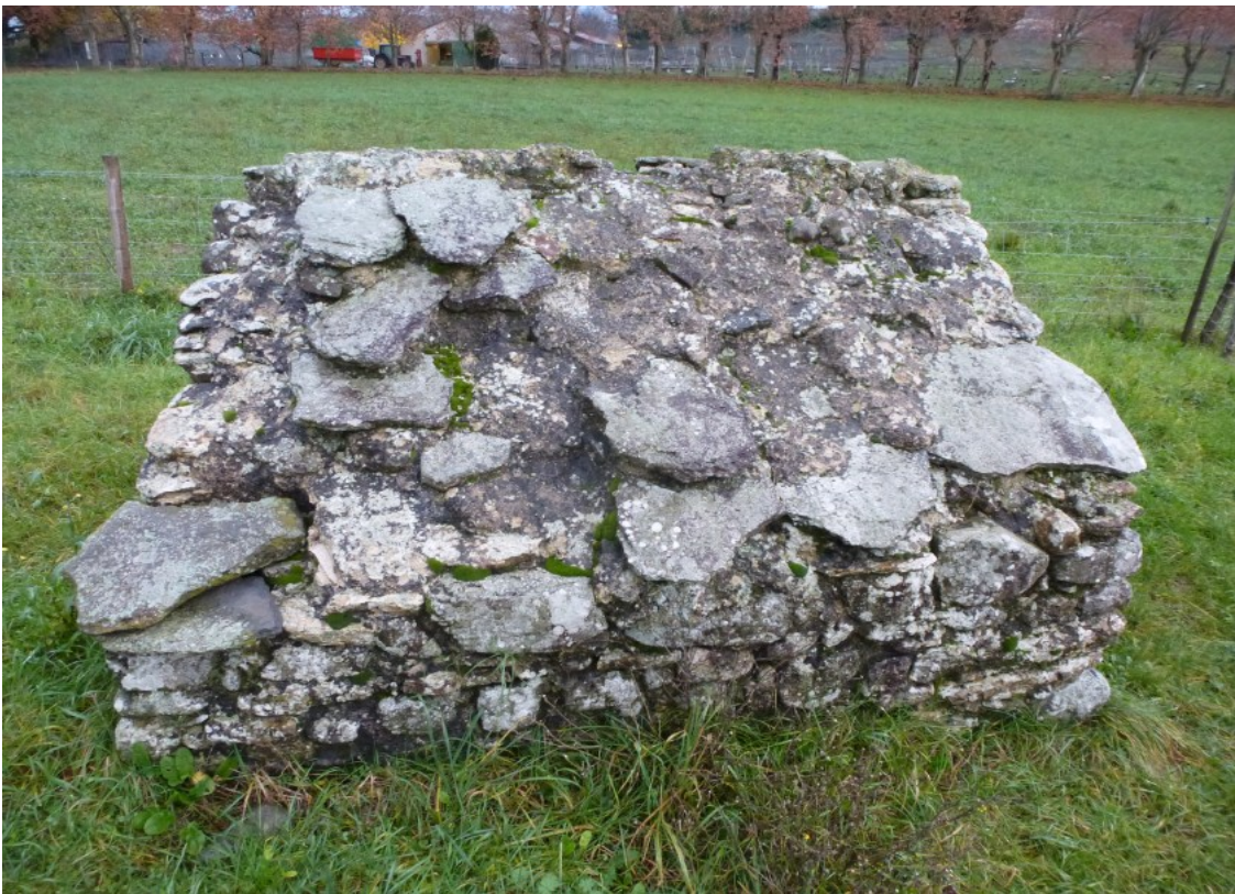
Mur et toiture Ouest
