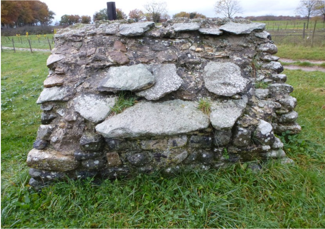
Mur et toiture Est
